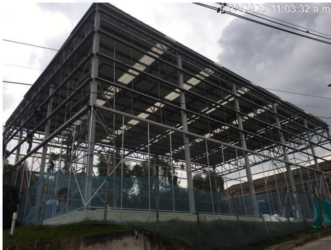
Ilustración 7 Imagen-cubierta en construcción barrio la Aldea
