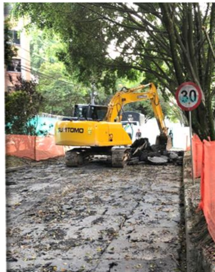
Ilustración 14 Imagen obra quebrada el Sesteadero, archivo de informes supervisión
