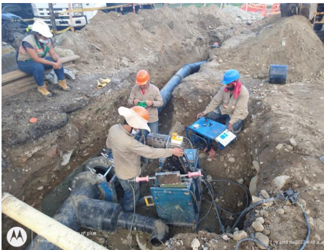
Ilustración 19 Construcción redes de acueducto y aguas lluvias Calle 75 barrio el Carmelo (zona urbana). imagen tomada de la obra en ejecución
