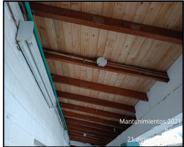
Ilustración 4 Imagen mantenimiento del techo I.E Esteban Ochoa
