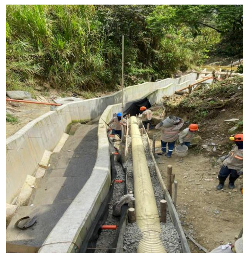
Ilustración 18 Construcción redes de Acueducto y Alcantarillado Vereda Los Gómez (Zona rural- corregimiento el manzanillo)
