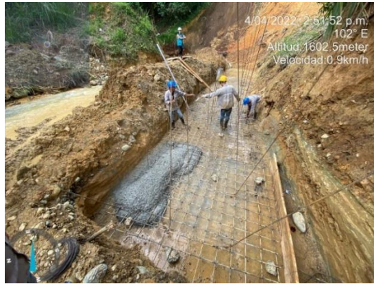
Ilustración 13 Imagen obra quebrada la Muñoz, archivo de informes supervisión
