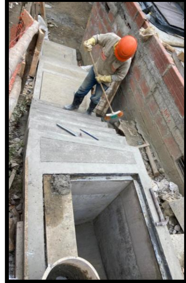
Ilustración 9 redes de acueducto Porvenir-Villa Sol
