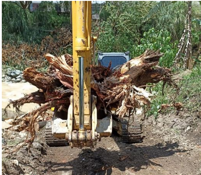
Ilustración 15 Imagen obra quebrada el Zanjón del Alto, archivo de informes supervisión
