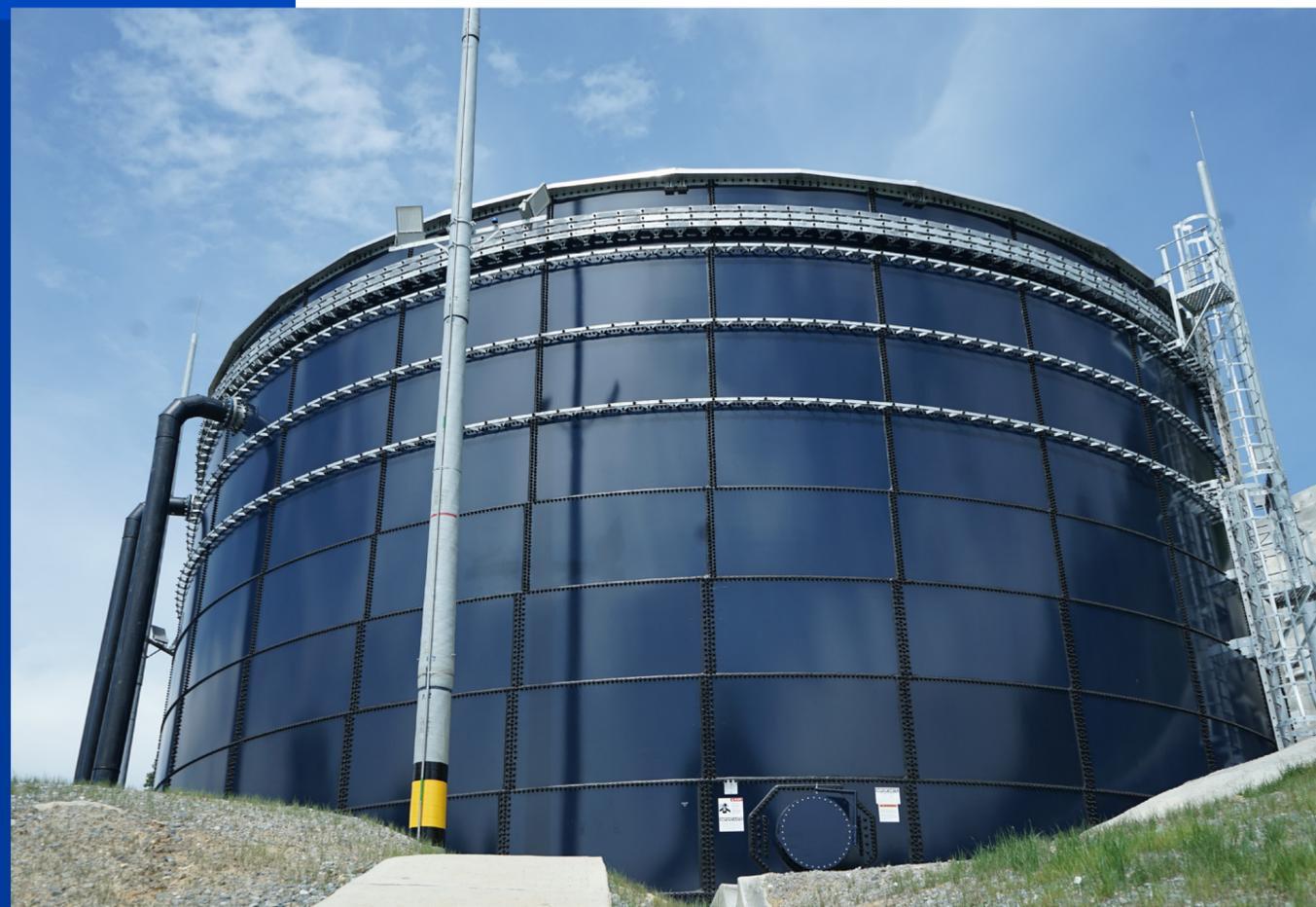
Terminación de obras de la segunda etapa del proyecto, consistentes en ejecución de las obras respectivas para la instalación del tanque superior de almacenamiento de agua fabricado en acero recubierto con vidrio fusionado (ENAMEL) con una capacidad aproximada de 390 m<sup>3</sup>
