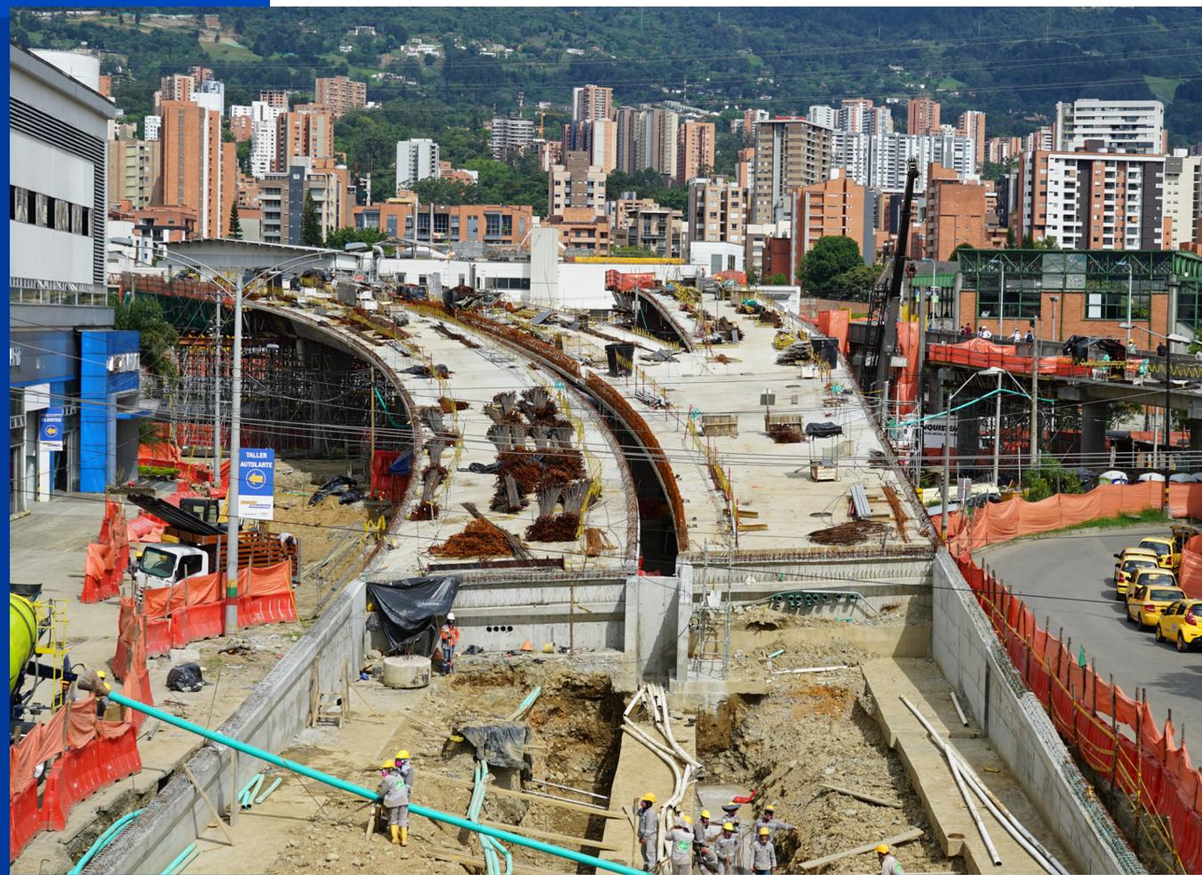
Este intercambio vial, con un avance de 91% de ejecución, estará conformado por 17 ejes viales con una longitud total de 6.2 kilómetros, distribuidos en 5 puentes con una longitud total de 1471,6 metros y 4750,4 metros de vías en rampa y a nivel.
