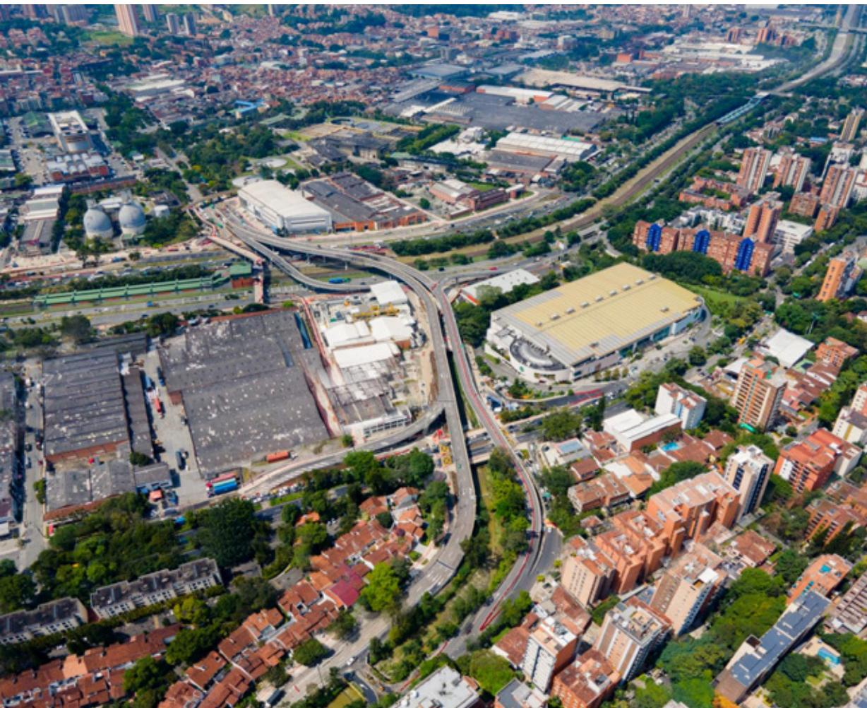
Conformado por 17 ejes viales con una longitud total de 6.2 kilómetros, distribuidos en 5 puentes con una longitud total de 1471,6 metros y 4750,4 metros de vías en rampa y a nivel.
