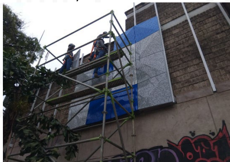
Ilustración 7 seguimiento supervisión: adecuación fachada auditorio norte
