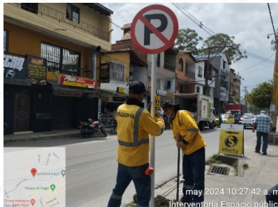
Instalación de señal Reglamentaria SR-28
